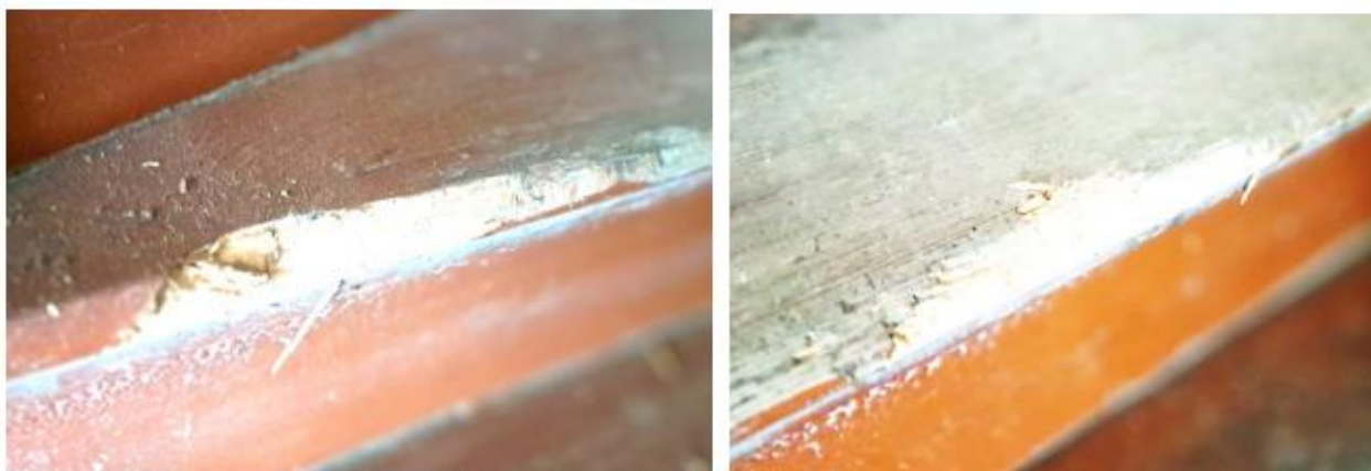
Porażenie stopnic schodowych przez „Kołatka domowego”.
