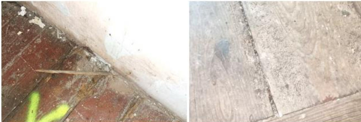
Porażenie podłogi „białej” przez „Grzyby domowy właściwy” (korytarz parteru). Żerowiska „Kołatka domowego” stwierdzone w deskach podłogowych (korytarz I piętro).
